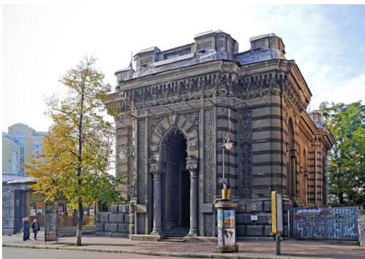
Будівля кенаси в Києві
