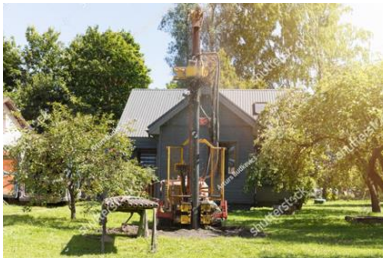
Мал. 9.9. Артезіанські свердловини у землі бурять спеціальними пристроями до глибини 100–1000 м залежно від розташування водоносного шару
